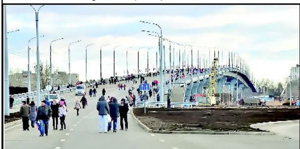
5. Мост Победы через судоходный канал в Балакове (2015)
